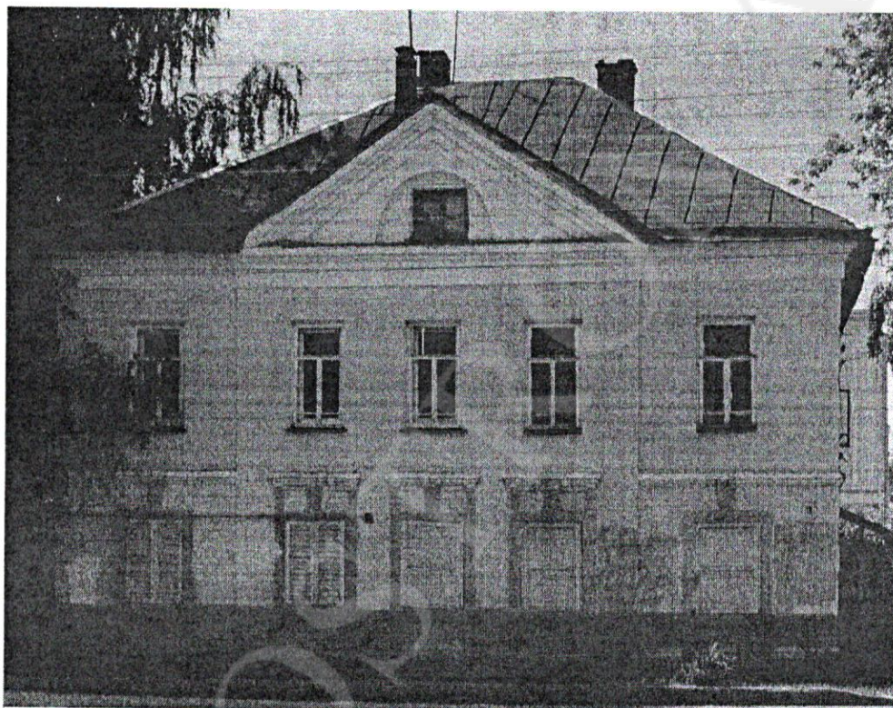
Фото 1. Вид со стороны главного (северо-восточного) фасада
